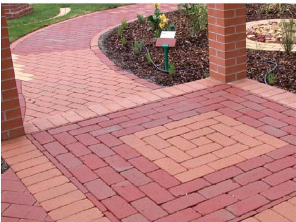
Szegély a ferde irányban lerakott burkolótéglából
