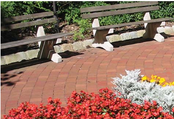
Két, nem azonos magasságú felület választóvonalá, egyoldalúan lerakott szegélykövekből kialakított szegély.
